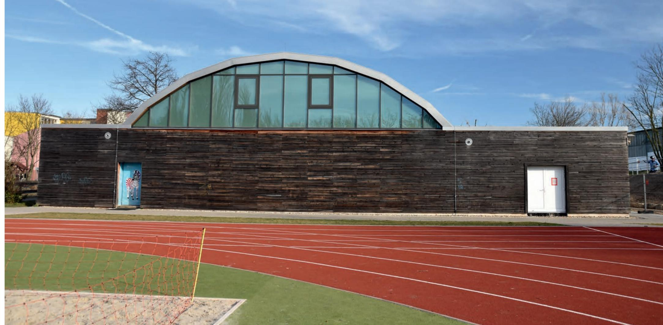
markante Gebäudeform aufweist. Die Netzstruktur beinhaltet Stützen im Abstand von 3 Metern, die bei der Sporthalle KT 60L in die Anbauten integriert sind. Die Konstruktion der nahtlosen Stahlrohre zu einem Netz bewirkt ein mehrdimensionales, mit einem der ersten Computerprogramme bemessenes Tragwerk.
